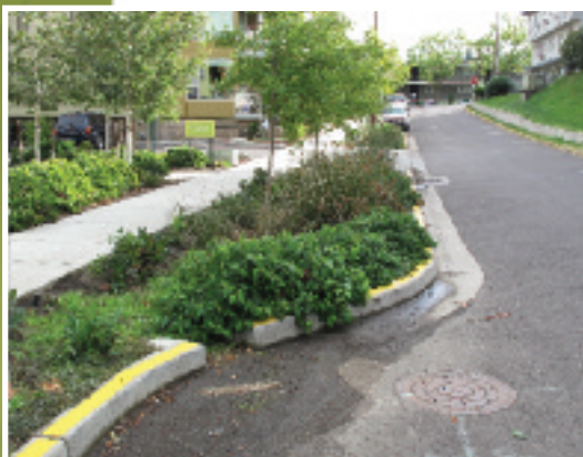
Marais filtrant (biorétention) pour la gestion des eaux pluviales d'une rue (photo J. Brisson)
